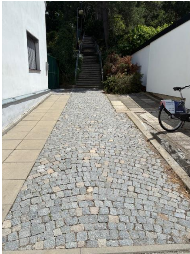
betonové stupně schodiště rozměr 2x0,35x0,18m žulová dlažba
