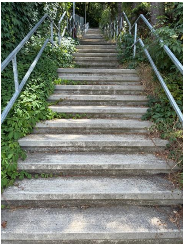
betonové stupně schodiště rozměr 2x0,35x0,18m žulová dlažba
